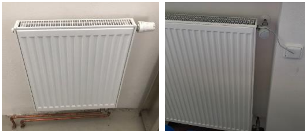
Obrázek 14 Deskové radiátory s regulačním systémem TRV (vlevo) a IRC (vpravo)
