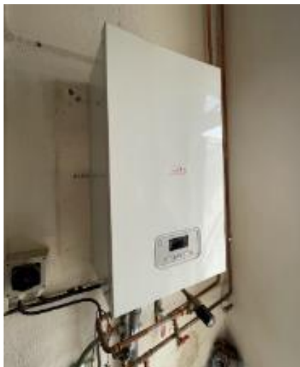
Obrázek 13 Elektroketel Protherm
