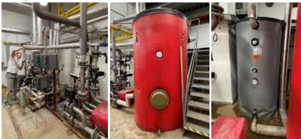
Obrázek 7 Deskové výměníky a akumulční zásobníky CORDIVAR 4000 l (uprostřed) a Dražice 1000 l (vpravo)
