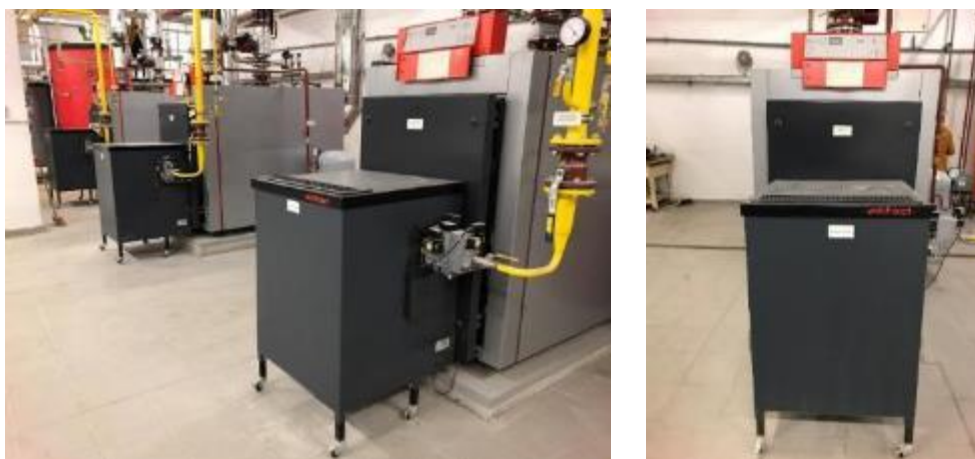
Obrázek 4 Plynové kotle K1-K3 Viessmann Vitoplex 300
