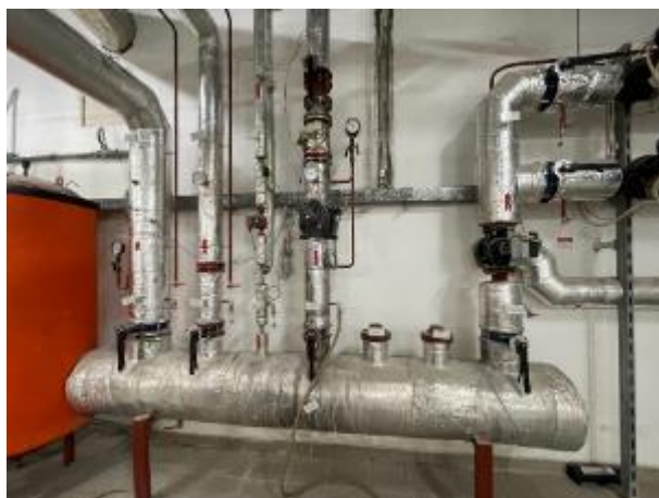
Obrázek 9 : Rozdělovač topné vody (vlevo), sběrač topné vody (vpravo)
