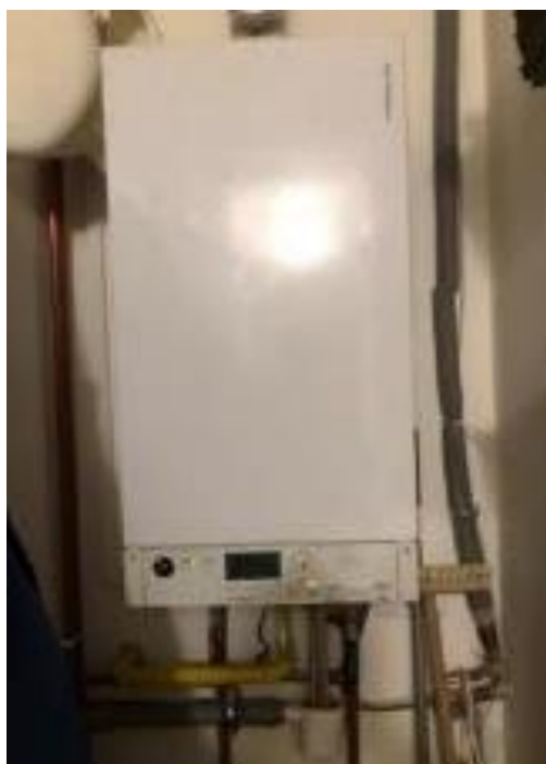
Obrázek 12 Plynový kotel Viessmann Vitodens 200
