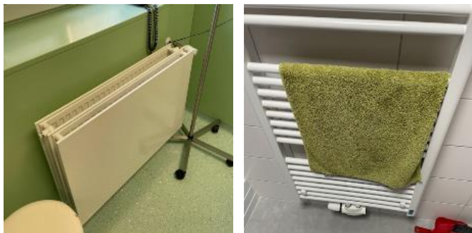
Obrázek 15 Deskový radiátor provedení Hygiene (vlevo) a koupelnový radiátor (vpravo)
