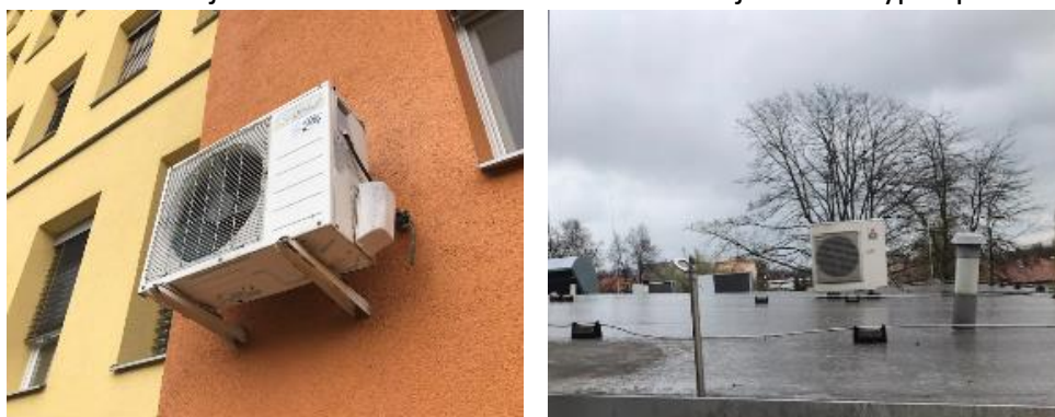
Obrázek 20 Klimatizační jednotky typu Split v areálu Stodské nemocnice
