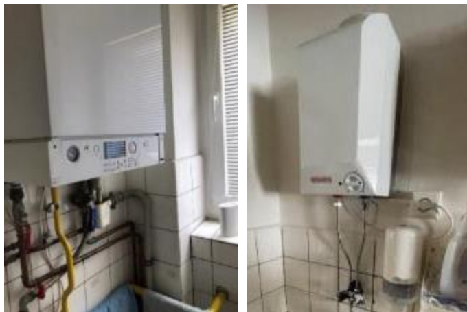
Obrázek 11: Plynový kotel Vitodens 200 (vlevo) a elektrický průtokový ohřívač (vpravo)
