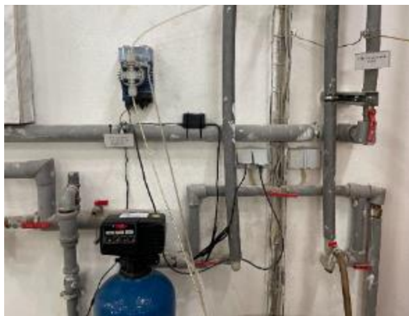
Obrázek 6 Automatická úprava vody
