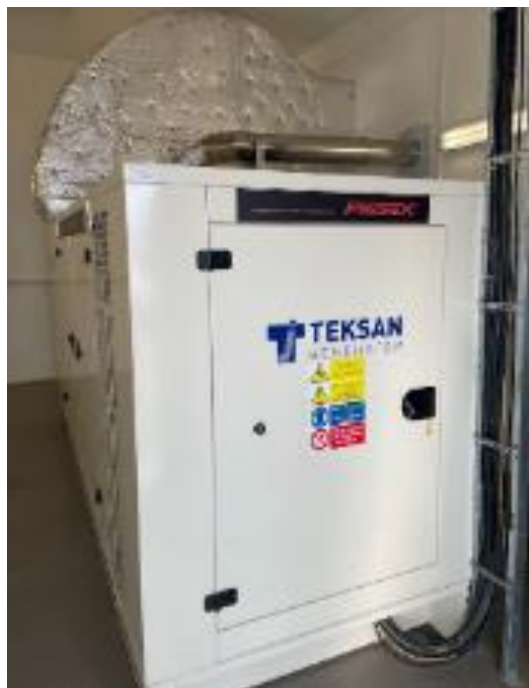
Obrázek 17 Záložní zdroj energie – dieselaagregát
