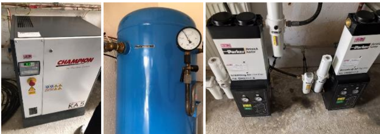
Obrázek 21 Kompresor (vlevo), vzdušník (uprostřed), filtry (vpravo)
