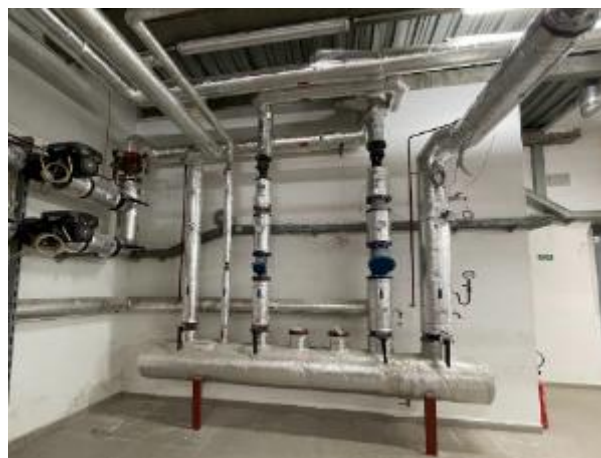
Obrázek 9 : Rozdělovač topné vody (vlevo), sběrač topné vody (vpravo)
