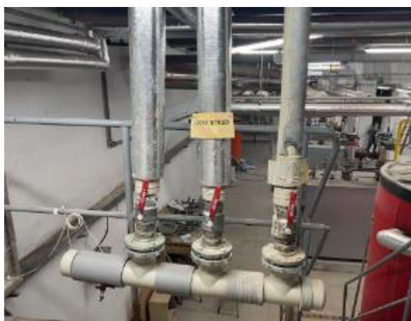
Obrázek 10 Rozdělovače teplé vody
